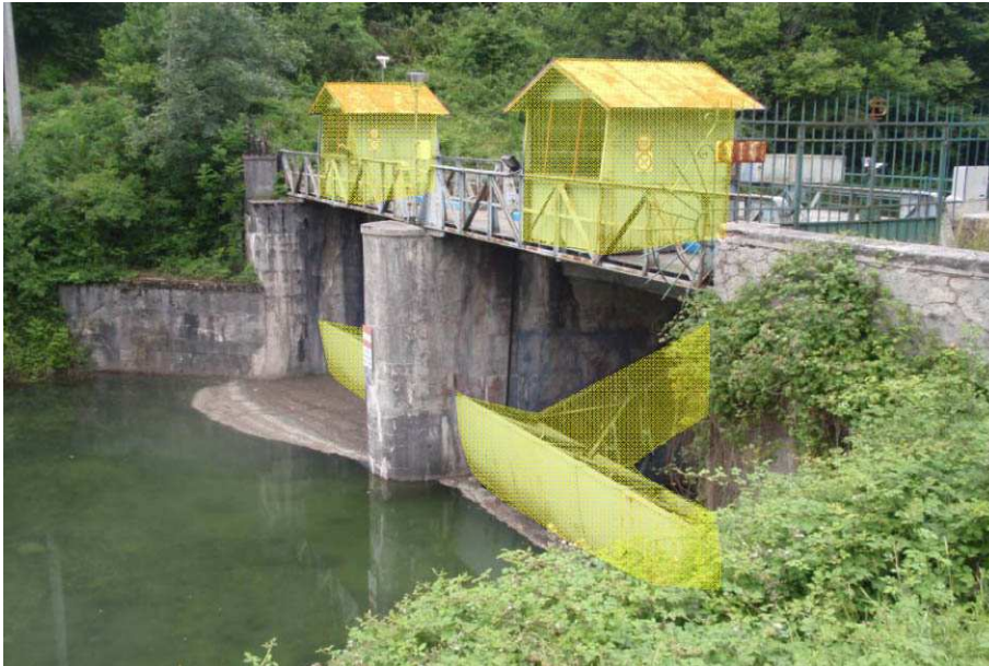
Figura 9: traversa esistente: evidenziate in giallo le strutture da demolire.
